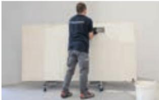
**IT 4\_** Stendere il collante sul retro della lastra utilizzando l'apposita spatola a denti quadrati (3x3 mm) e accertarsi che le righe dell'ultima stesura siano nella stessa direzione di quelle della spalatura della lastra. Durante la fase di stesura, la lastra dovrà essere in posizione verticale e fissata al telaio di movimentazione con ventose di sicurezza posate sopra al carrello per il trasporto con ruote.
